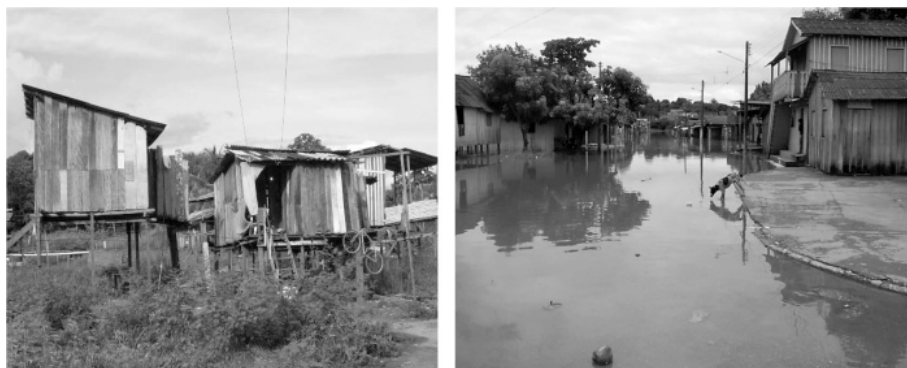
Figura 06: Ocupações irregulares nas margens do bairro Caetano Filho. Fonte: FALCÃO, 2007.
